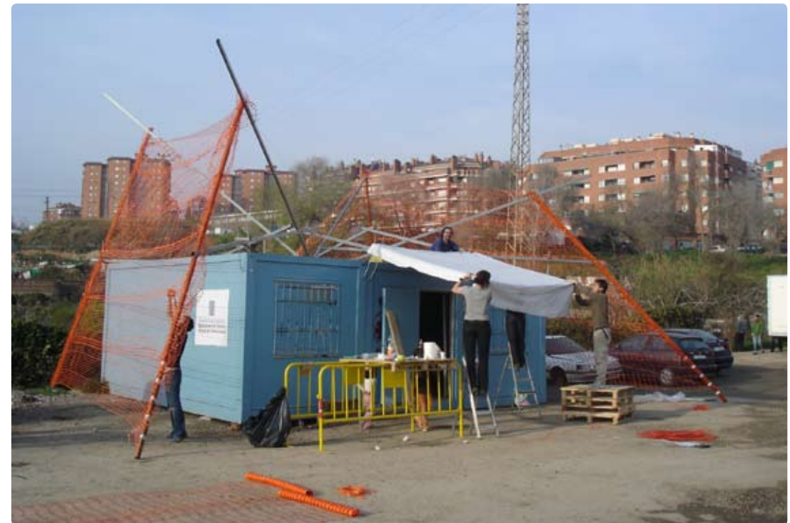
Spaider3. Esplugues de Llobregat, 2008. Procés de construcció.
