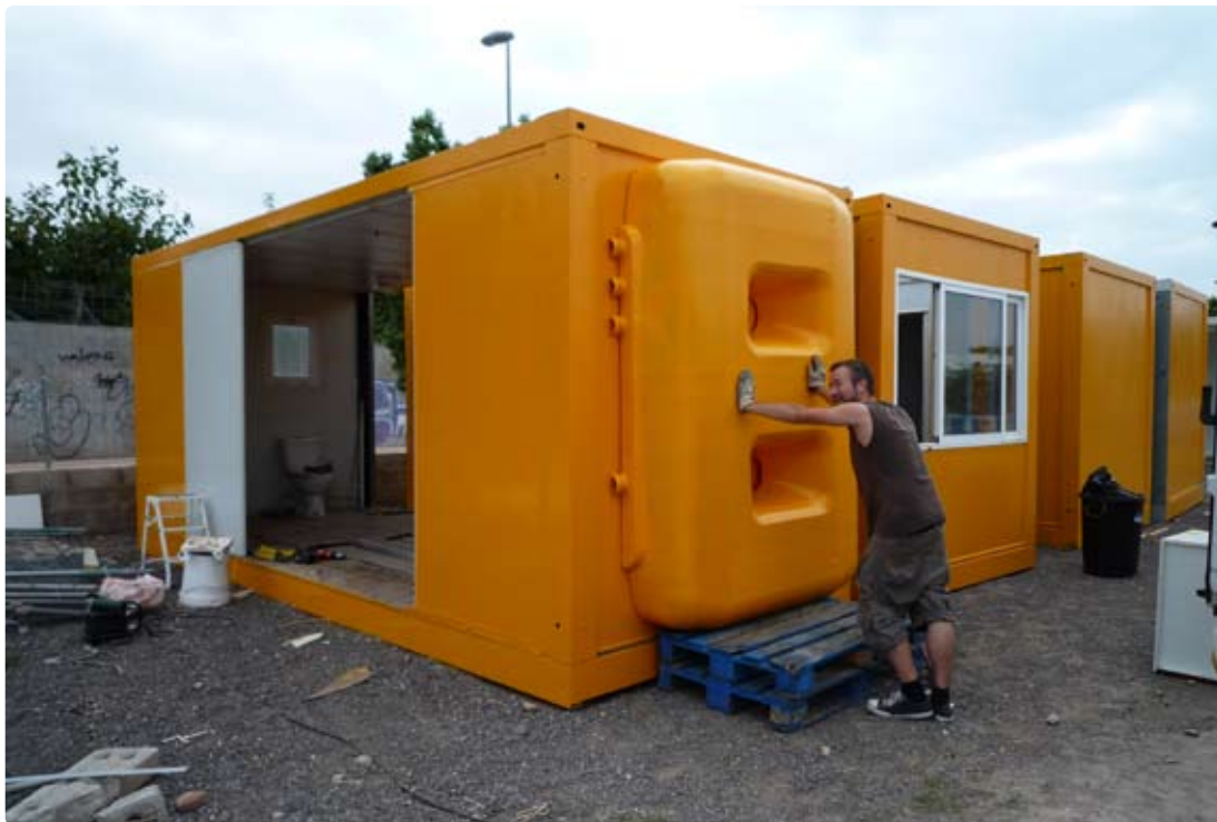
Proyectorlab Benicàssim. Plaça Estació s/n, Benicàssim, 2010. Procés de construcció.
